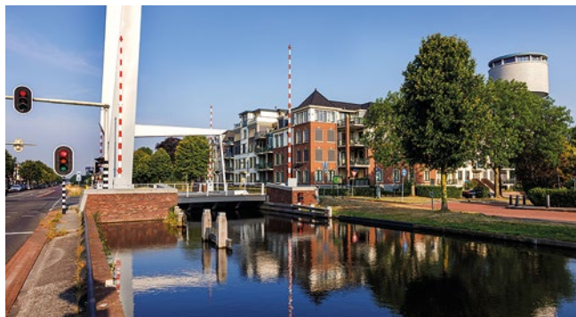
DE WITTERBRUG IN ASSEN
