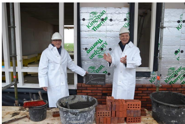
In de pijplijn: 35 woningen te Bedum van Wierden en Borgen
