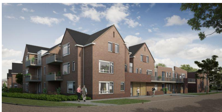
Nieuwbouw 2012: Woonborg 21 seniorenappartementen Peize
