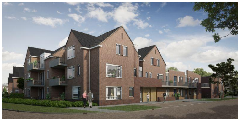
Nieuwbouw 2012: Woonborg 21 seniorenappartementen Peize
