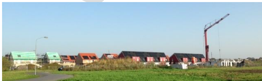
In aanbouw: "De Vosholen" Hoogezand-Sappemeer (foto Ramon Hoogeeven gemeente HS)
