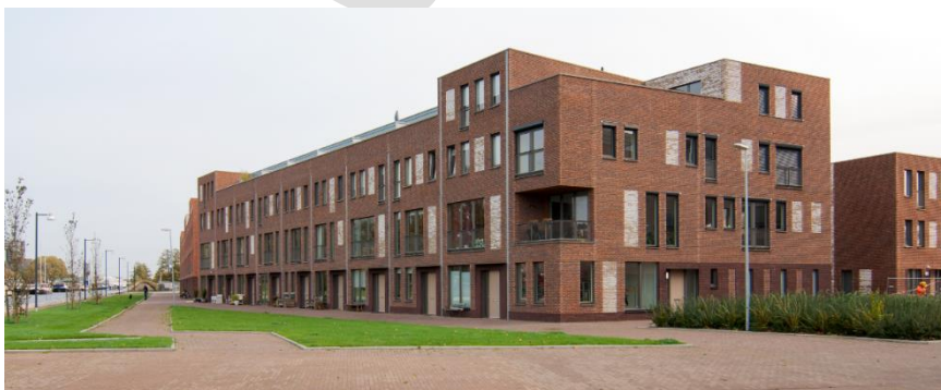
Opgeleverd: Eemskwartier fase 2 Groningen (foto Cor van der Veen gemeente Groningen)
