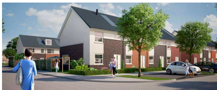
Nieuwe verhuur energiezuinige huurwoningen Noordenveld
