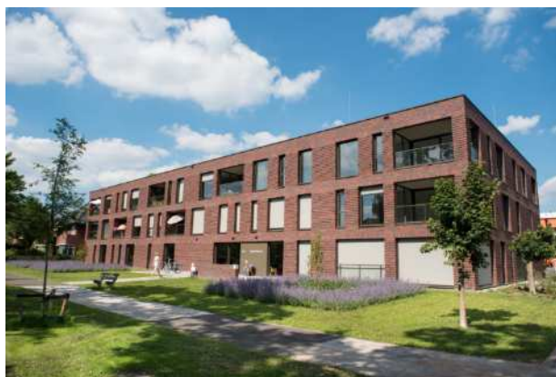
Vervangende nieuwbouw zorgcentrum Westerland Haren
